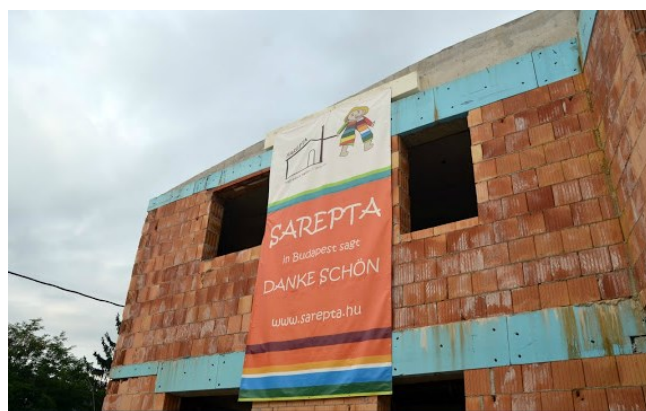
Neubau des Alten- und Behindertenheimes Sarepta
